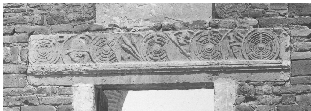
11. Architrave con fregio d'armi nella chiesa di San Zeno a Cerea (da FERRARESE, In conformità , fig. 29).
