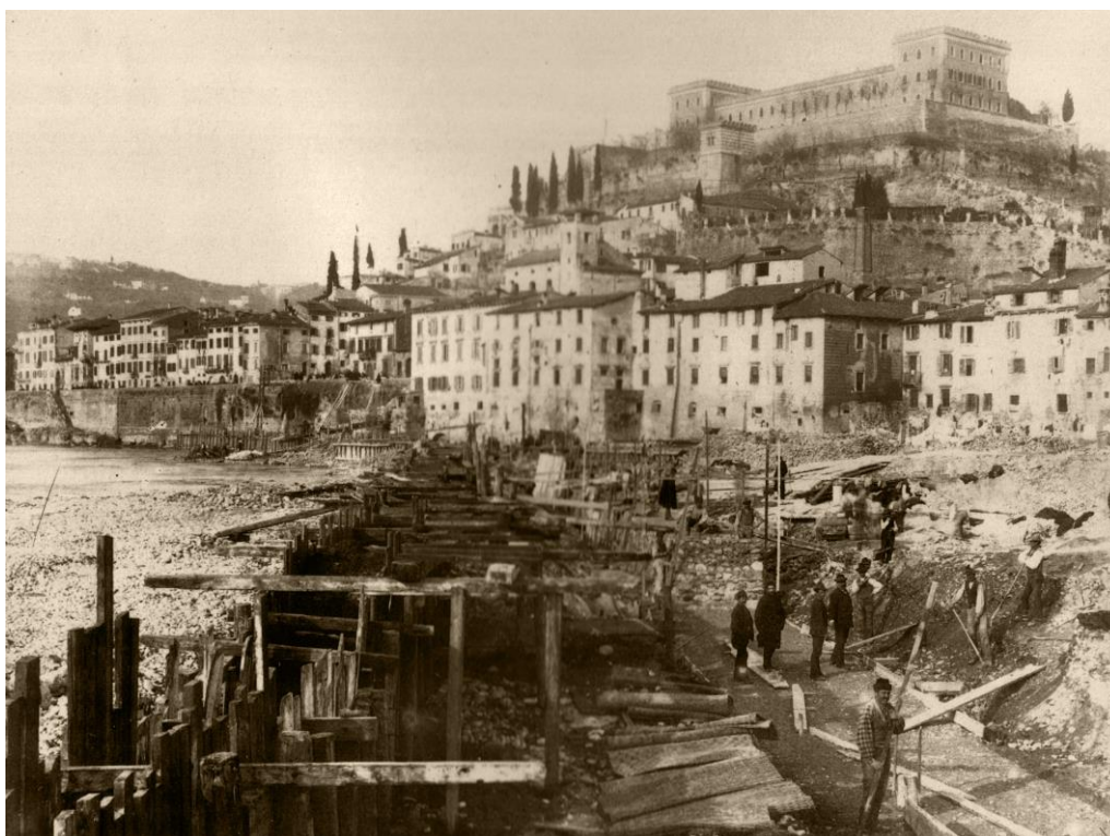
L'isolato Spitz durante la costruzione dei muraglioni in due foto di Oddone Pasoli (1892) e Giuseppe Bertucci (1891).
