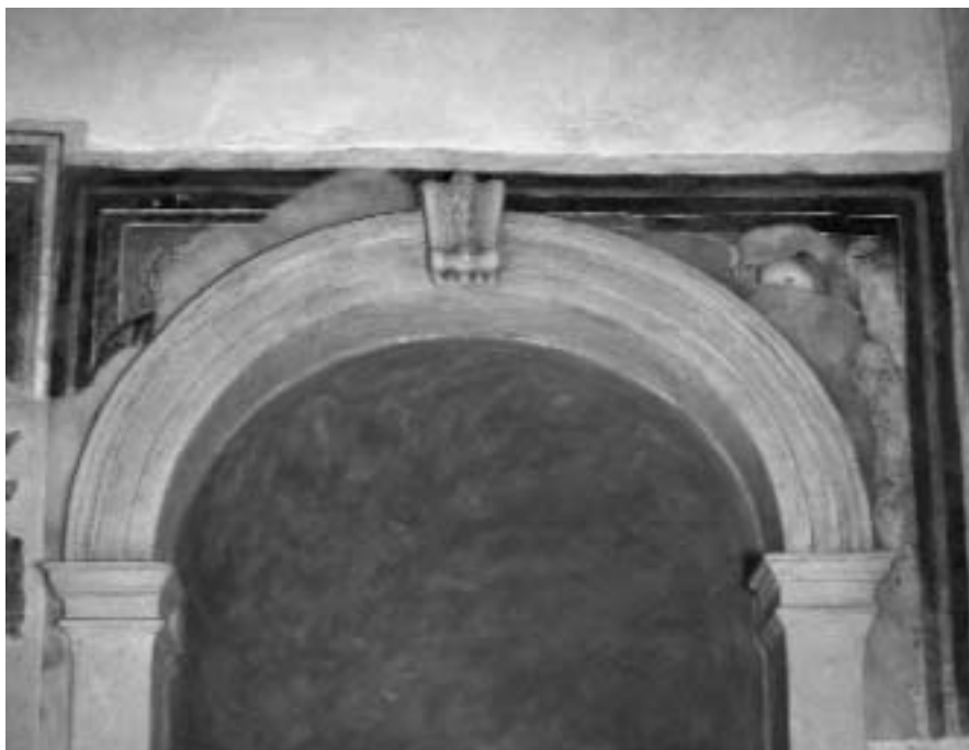
San Michele: riquadro frammentario sulla parete superiore di settentrione pressoché distrutto dall'apertura della cappella cinquecentesca con l'ipotizzata Apparizione dell'angelo a san Pietro in vincoli .
