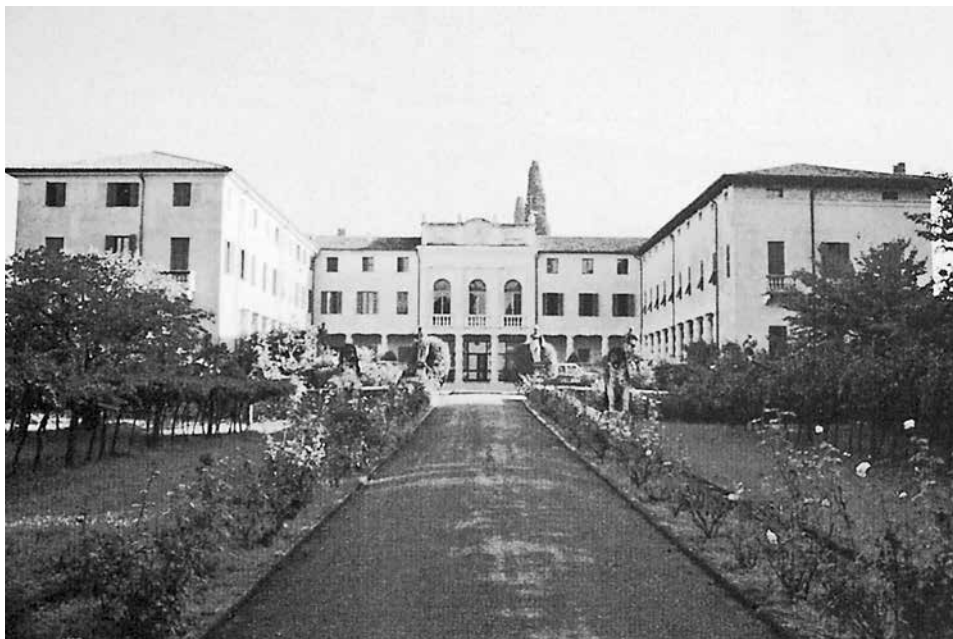
Il fronte meridionale visto dall'ingresso del giardino.
