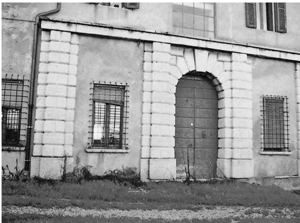
La porzione centrale del prospetto occidentale.
