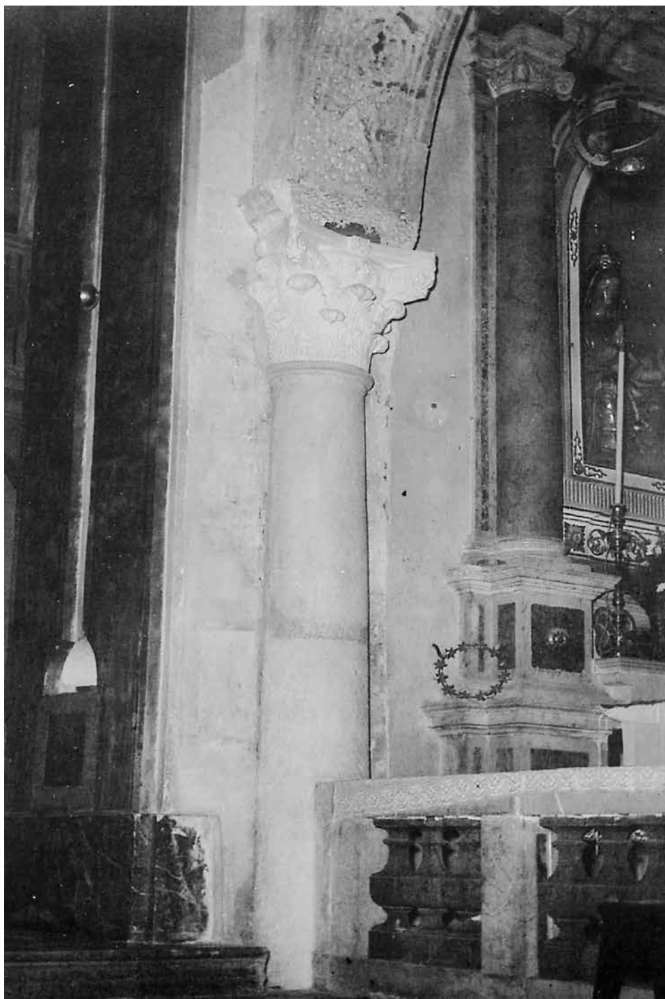
“Riproposta” di un capitello romanico realizzato in occasione dei restauri del 1961, collocato a destra dell’arco santo.
