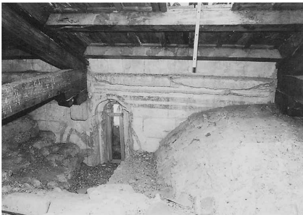
Particolare del sottotetto della navata centrale con elementi lignei decorati.
