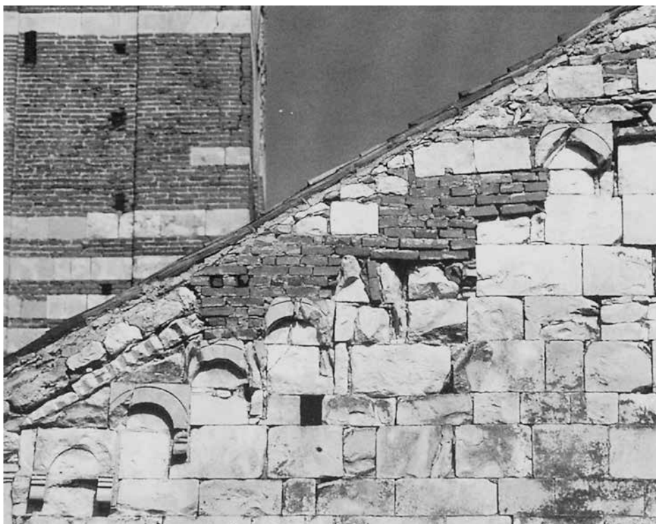
Particolare della cornice con archetti pensili dell'ala sinistra con evidenti sostituzioni delle parti degradate.
