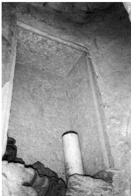
Vano ricavato nello spessore del muro della scala, allestito con lastre di pietra e utilizzato come latrina.
