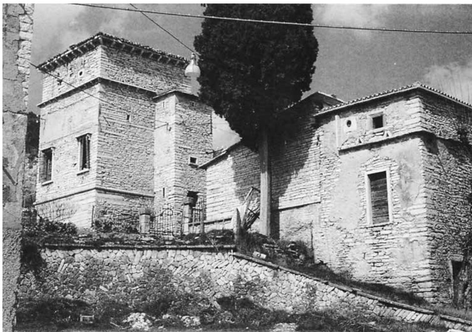
Fig. 18. Torre Colombara di contrada Castello a Prun.
