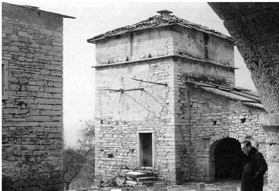
Fig. 2. Torre Colombara della corte Zivelongo.
