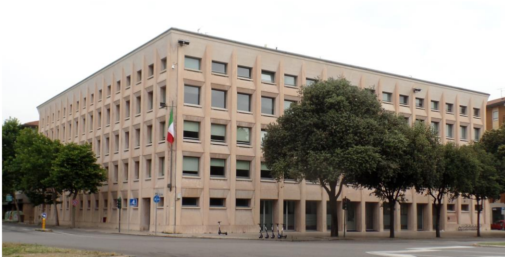
Sede attuale della Camera di Commercio, sorta sull'area ex GIL; l'edificio, progettato dall'architetto Libero Cecchini e dall'ingegner Angelo Tomelleri, fu inaugurato il 4 dicembre 1971 dal sottosegretario al Tesoro Mario Formenton.
