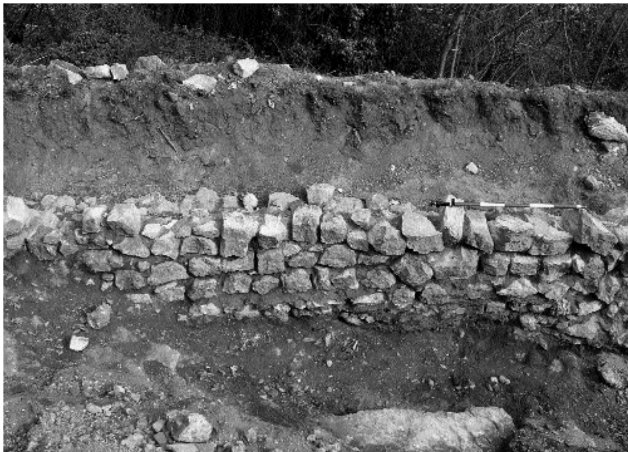
Castello di Marano. Tratto della muratura nord-orientale (USM 10).
