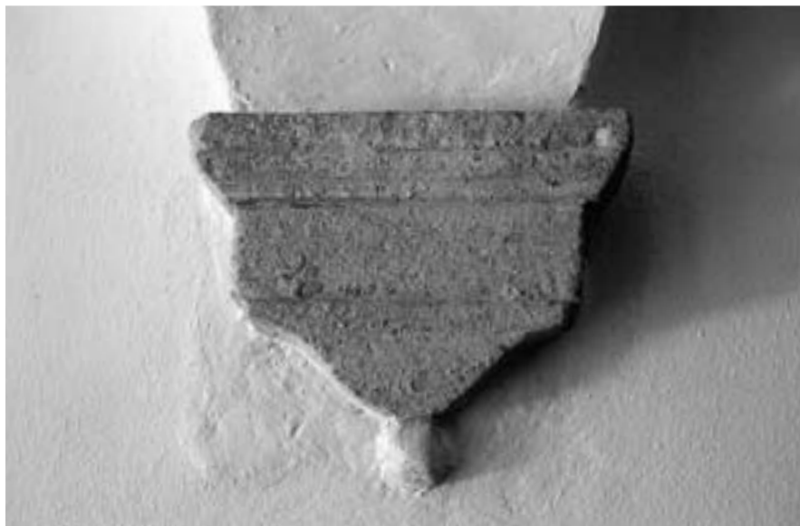
Peduccio in marmo a sostegno delle vele.
