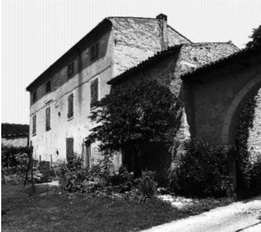
Il prospetto esterno dell'edificio rusticale che chiude la corte a sud.
