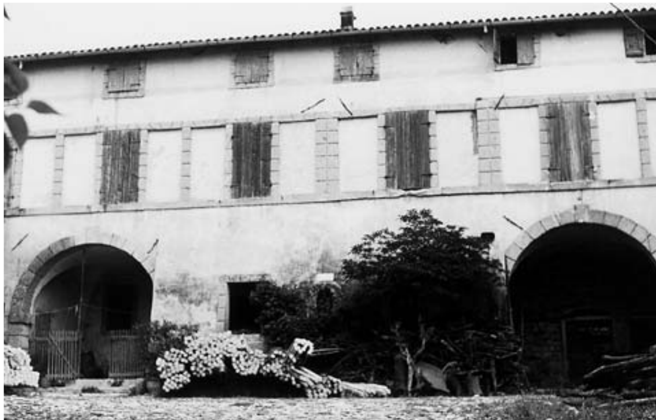
Casa Capetti-Borghetti prima dei recenti interventi di restauro (1980 circa).
