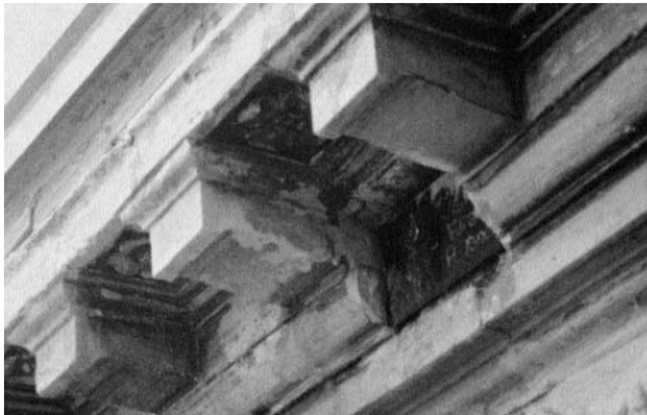
Fig. 30. Cornicione durante l'ultimo restauro; alloggiamento dei cavi metallici tra le mensole, prima che la placca metallica venga coperta con l'intonaco.
