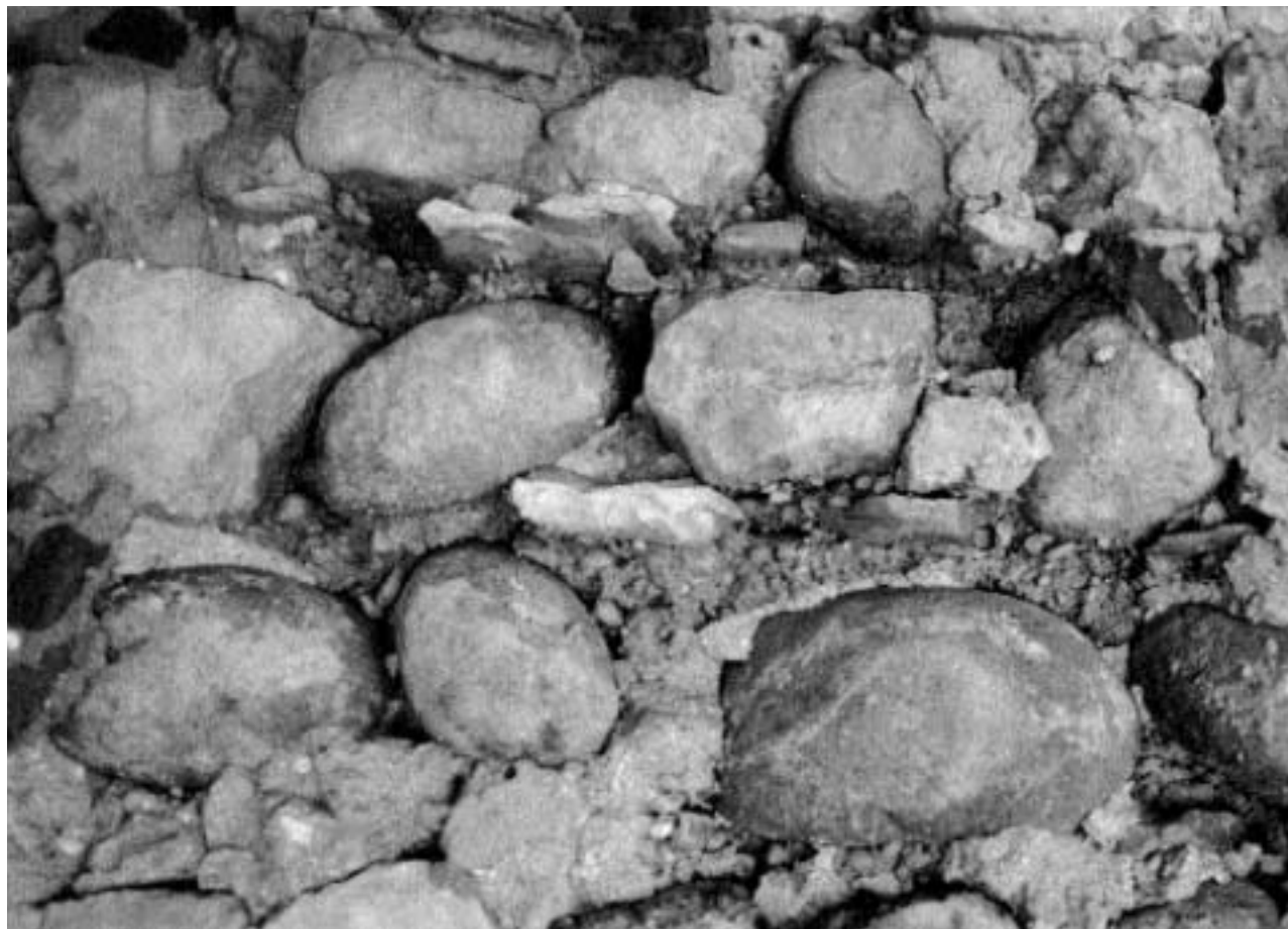
Fig. 12. Muratura del lato est prima dell'ultimo intervento.
