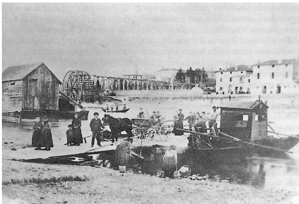
Le sponde dell'Adige a Settimo all'inizio del Novecento. Si notino il traghetto, il mulino galleggiante e, sullo sfondo, le ruote idrovore e il canale pensile che servivano a irrigare i terreni di proprietà Bertoldi.
