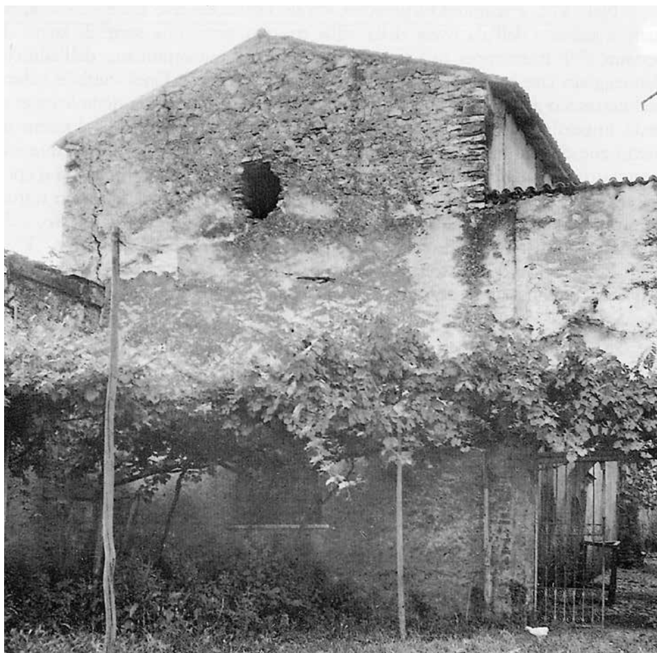
L'ingresso delle scuderie prima del crollo del 1972.
