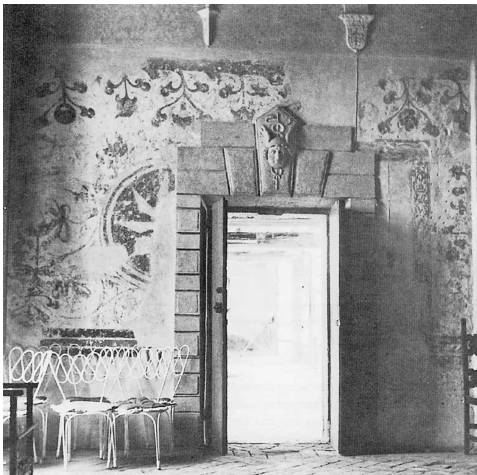
Tracce di affreschi in uno dei saloni del piano terreno della villa.
