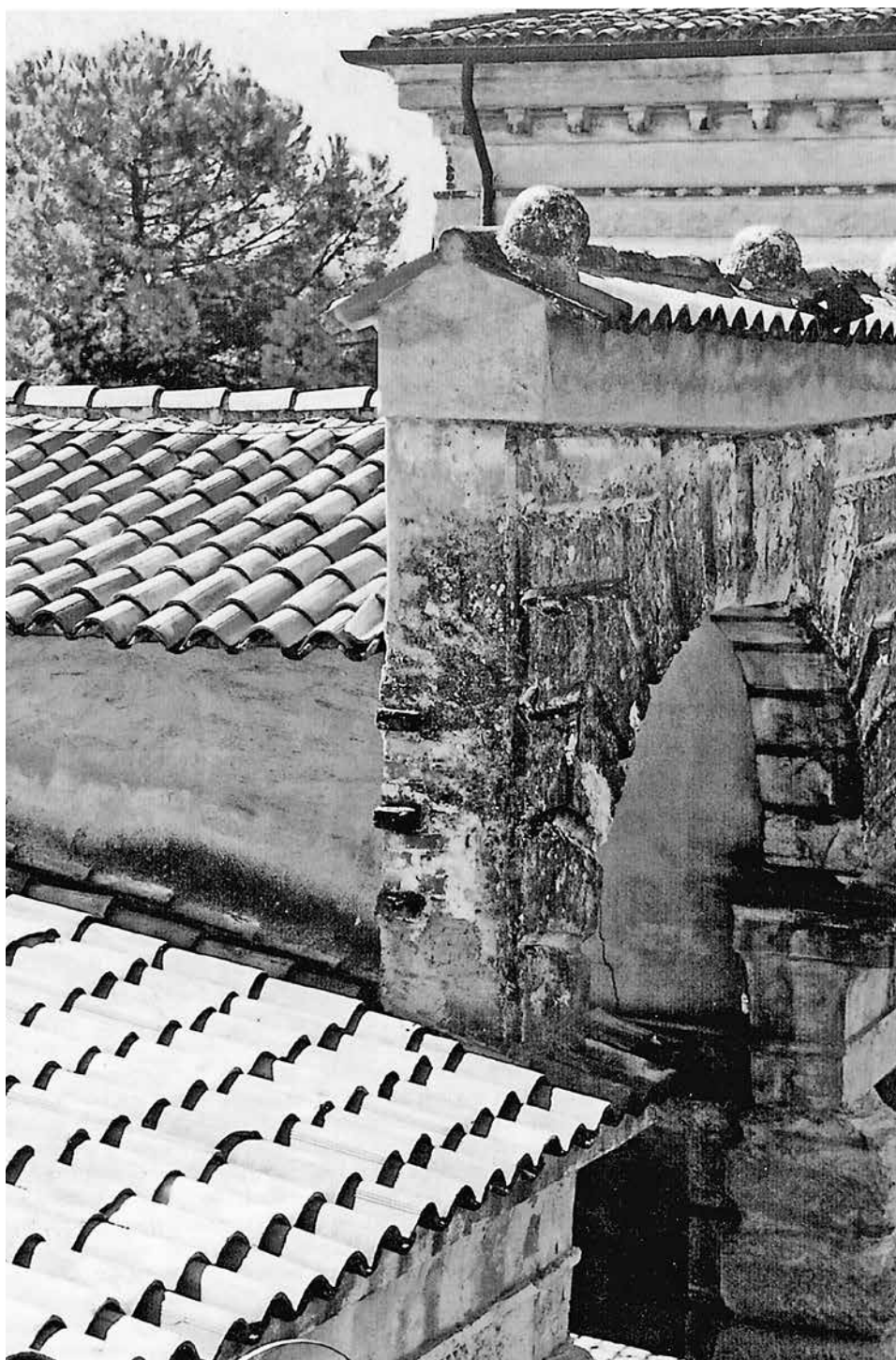
I resti dell'ammorsatura su uno dei portali del peristilio.
