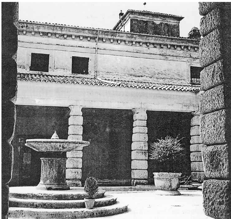
Il peristilio durante i lavori di restauro del 1960. Si noti il particolare dei capitelli e della trabeazione inopportunamente manomessi.
