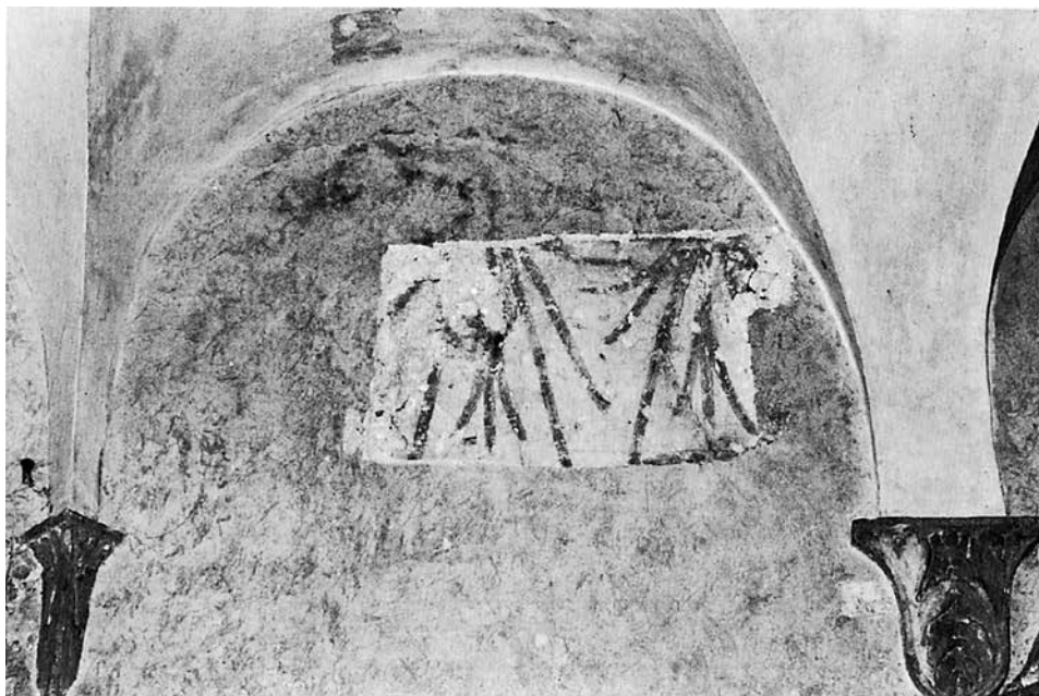
Il saggio stratigrafico al di sopra di uno dei camini al piano terreno mette in luce un motivo a drappo appartenente in origine alla decorazione "bassa" dell'ambiente soprastante.
