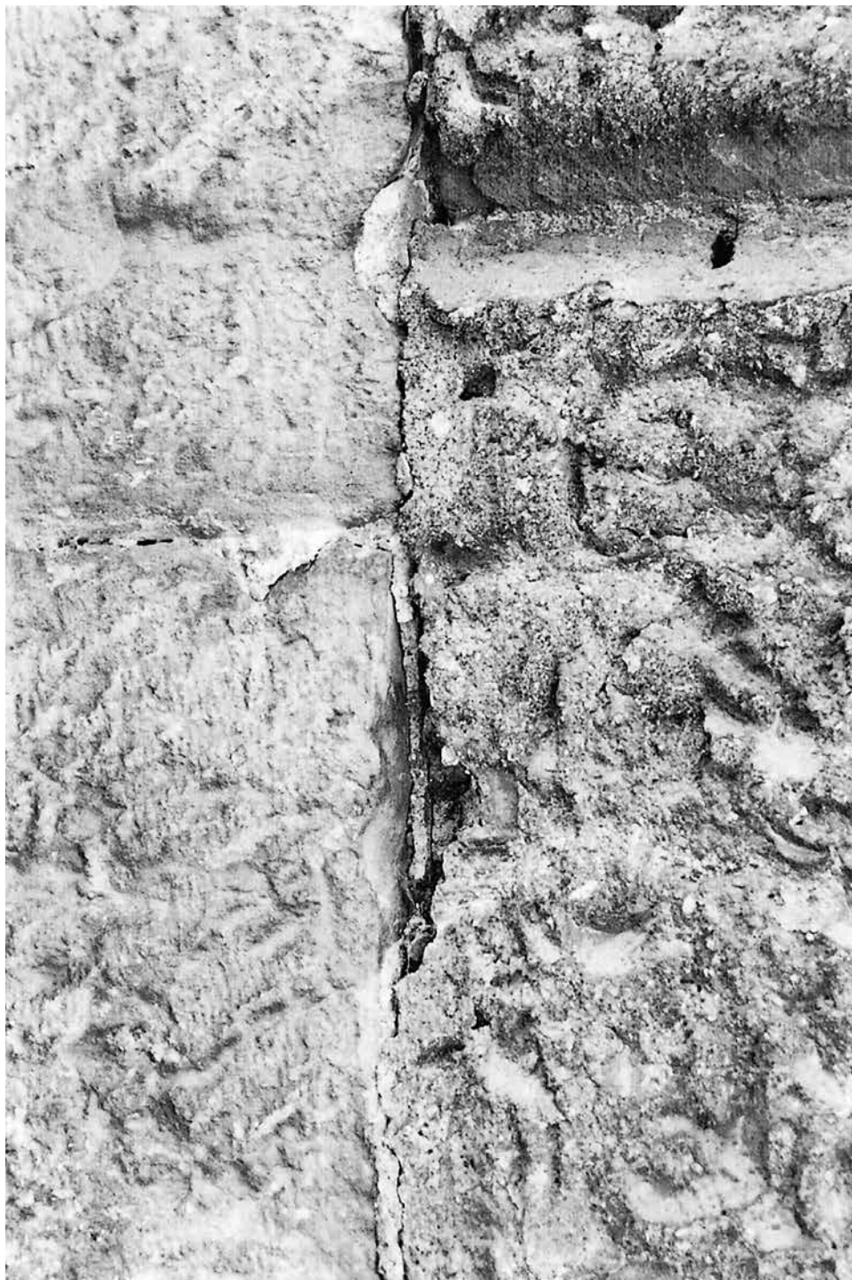
Particolare della porta di accesso al peristilio, in cui si evidenzia la presenza dell'intonaco su una delle due facce opposte di cesura tra il portale e la muratura sottostante.
