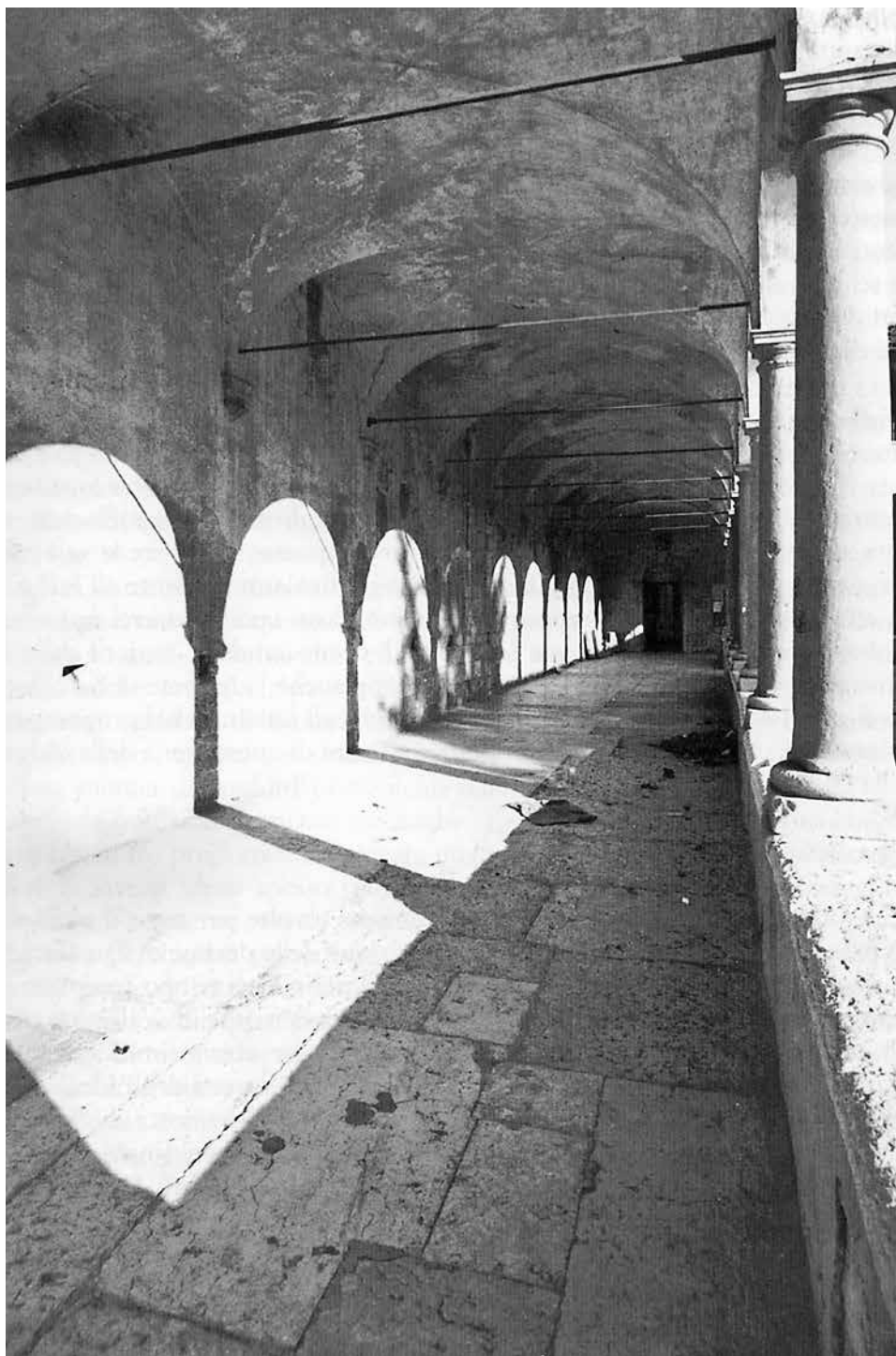
Il porticato seicentesco della pieve eretto con ogni probabilità in sostituzione di un precedente chiostro romanico.
