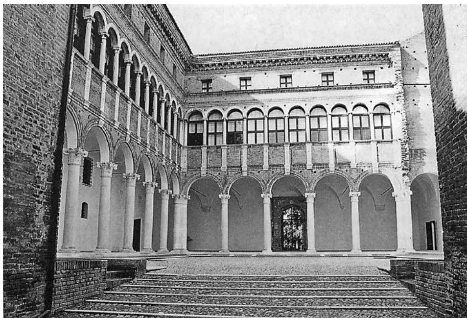
Palazzo Costabili, detto «di Ludovico il Moro» (1500 circa-1503). Ulteriore conferma della stretta collaborazione tra l'architetto Rossetti e il lapicida Frisoni proviene da questo palazzo, esempio apprezzatissimo di architettura rinascimentale, che ha messo in luce le capacità artistiche del nostro lapicida.
