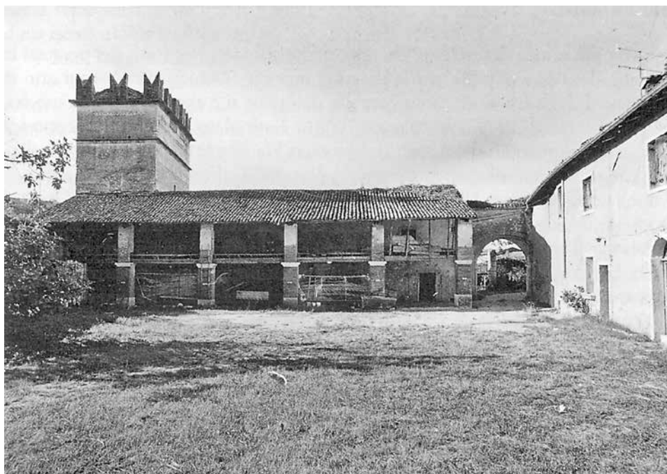
Il cortile principale di casa Marano, ora Cerutti, in contrada Osan con portici, fienili e torre colombaia (prima della ristrutturazione).
