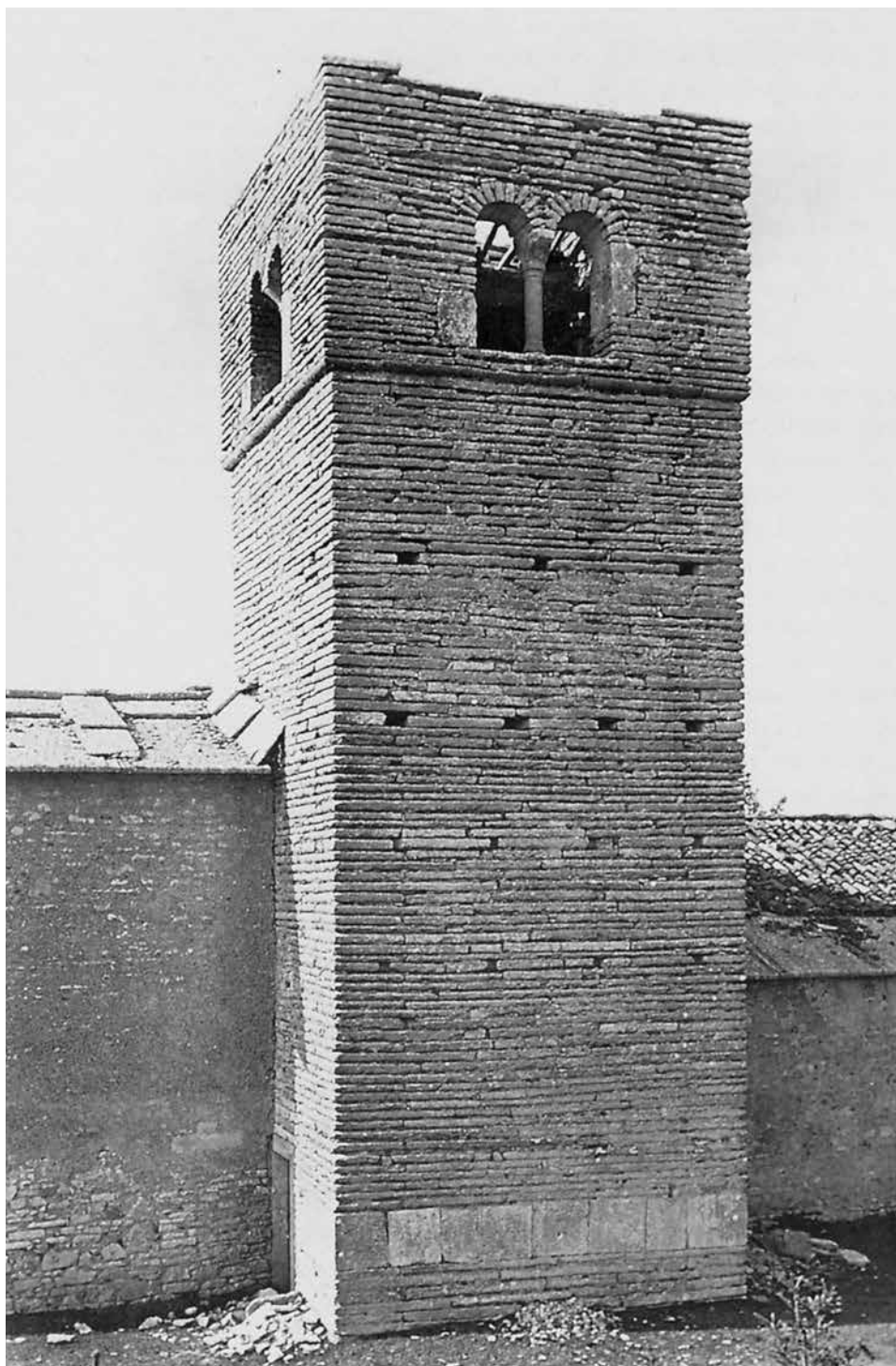
Il caratteristico campanile interamente costruito in oietra viva (lastame).
