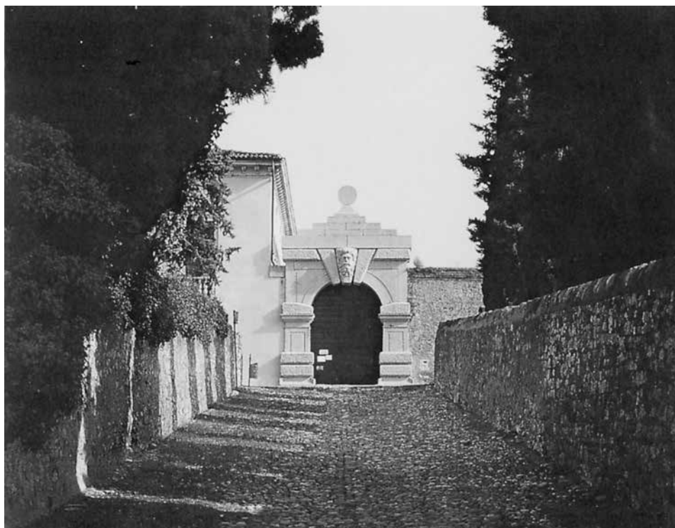
Il portale cinquecentesco e il viale di cipressi che conduce all'Adige.
