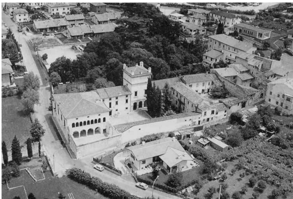
Veduta aerea della situazione attuale di villa Del Bene.
