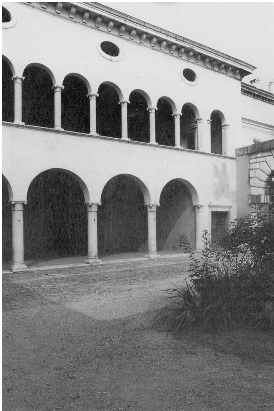
Il loggiato quattrocentesco. In alto sono visibili le tre finestrelle ovali fatte aprire da Benedetto Del Bene, nel 1776, per aerare il granaio.
