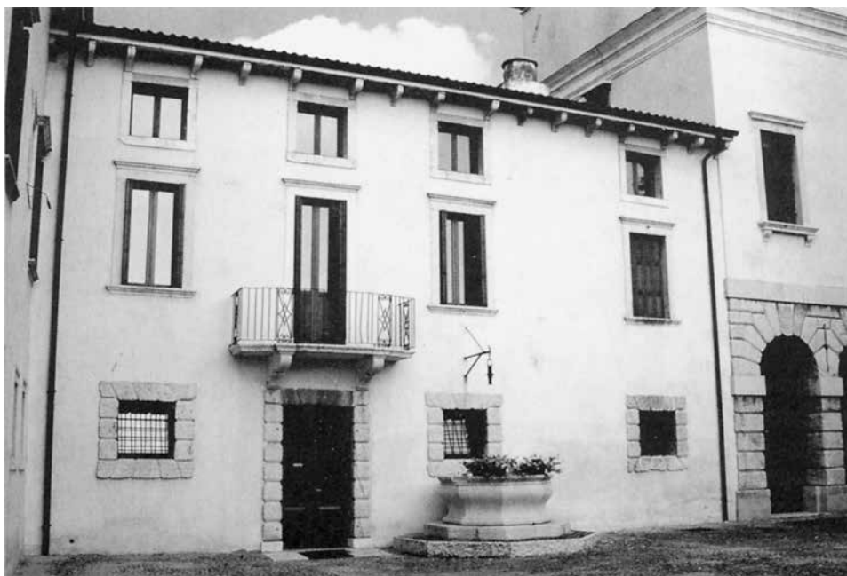
Corte del pozzo: ala a sinistra della torre colombaia. Il prospetto sulla corte fu quasi completamente rifatto da Benedetto Del Bene nel 1773-1775. Vennero redistribuite quasi tutte le finestre, rifatta in pietra la cornice di gronda e collocato il poggiolo.
