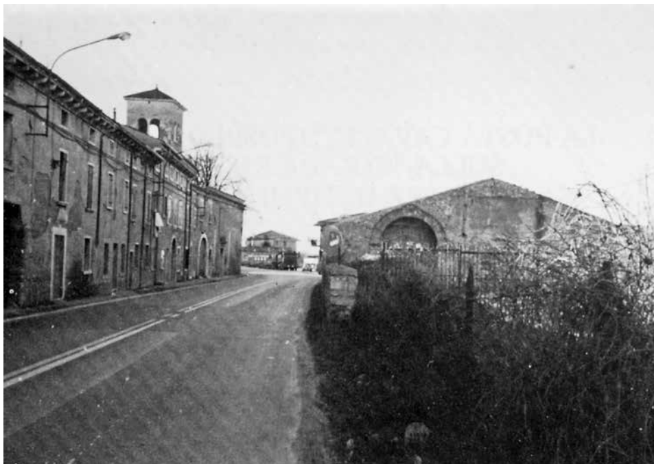
La “Strada Regia” del Tirolo a Ospedaletto: sulla sinistra l’edificio della “posta”.
