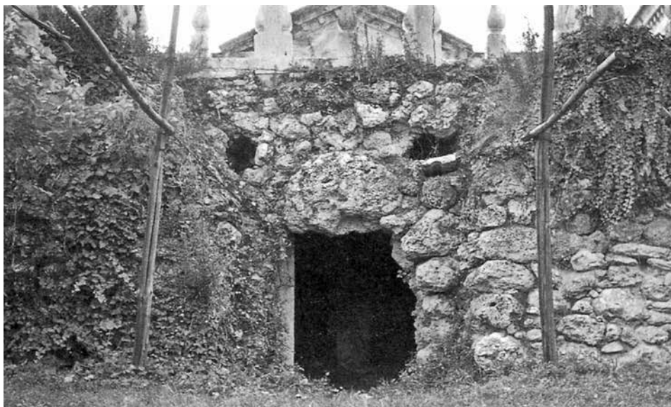
Villa Della Torre. Ingresso a mascherone della grotta del giardino.
