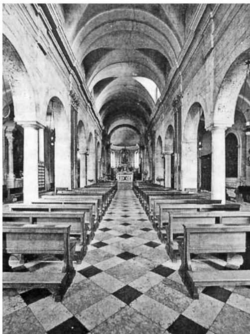
L'interno della chiesa romanica di S. Floriano, la pieve che aveva giurisdizione su tutta la Valpolicella centrale.
