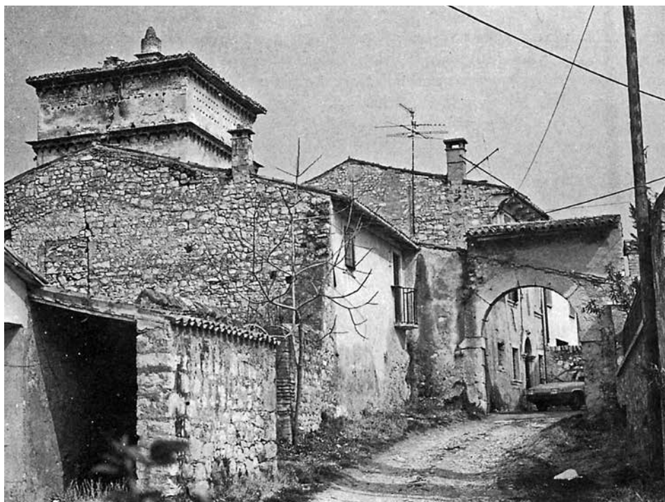
Fig. 6. La zona dell'arco d'ingresso vista dall'interno della corte: si notino il vuoto lasciato dall'edificio demolito, la prima torre-colombara in prossimità dell'ingresso e le tracce sopra l'arco dell'antica copertura.
