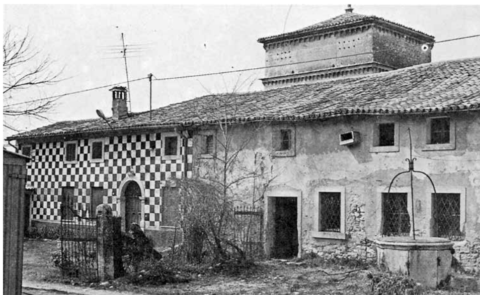
Fig. 5. L'edificio posto lungo il lato nord della corte, appoggiato a una delle due torri-colombare; la parte in primo piano era, in origine, un porticato aperto con pilastri quadri in bugnato.
