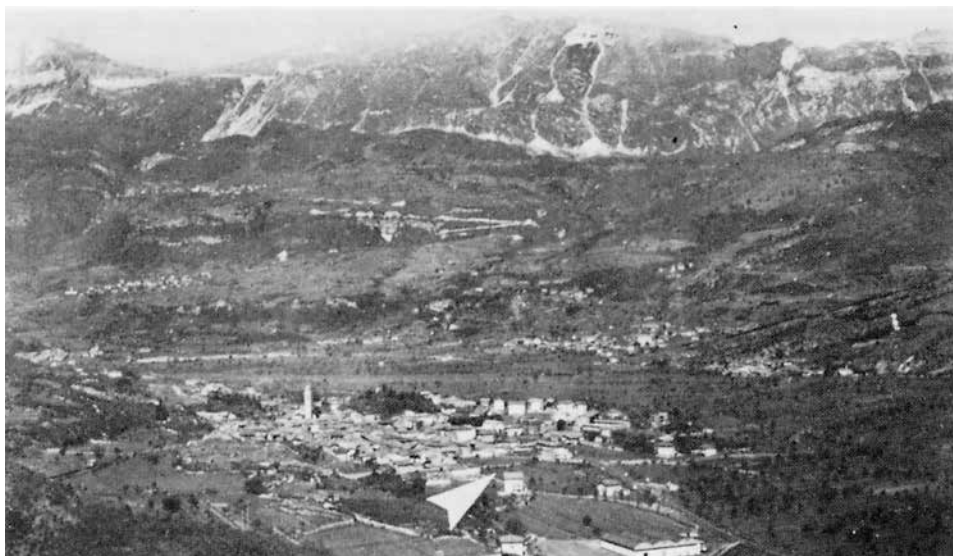
Fig. 2: Panoramica sulla valle dell'Adige all'altezza di Volano. La freccia indica l'area di scavo prima dell'inizio dei lavori.
