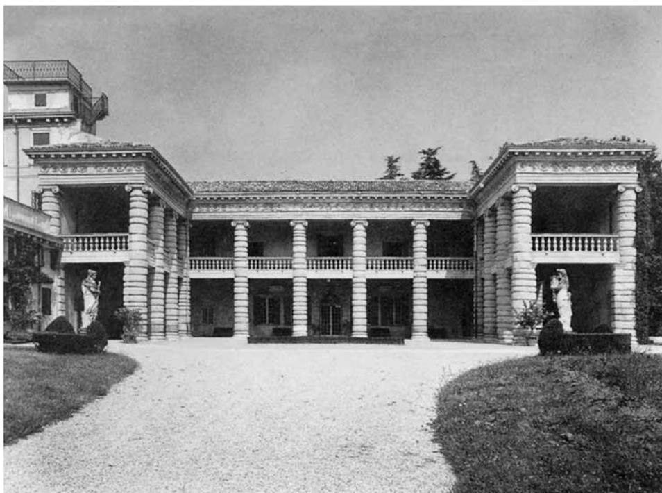
*A. Palladio: la metà realizzata del cortile interno della villa. Trabeazione e tetto, in corrispondenza delle fronti dei due "bracci", non sono interrotti. Il corpo di fabbrica a sinistra è forse il frutto di radicali trasformazioni e di ampliamenti di strutture preesistenti. La torretta con la terrazza sembra un'aggiunta assai tarda, probabilmente dovuta al Trezza (primi decenni dell'Ottocento).*
