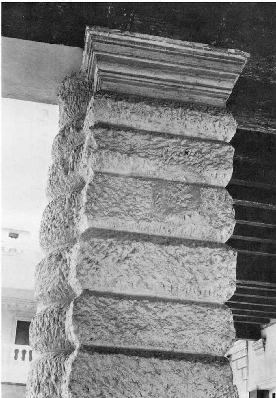
*Particolare del pilastro parastatico in corrispondenza della colonna angolare. È evidente che i blocchi rustici sono stati ricavati da un solo pezzo. Osserva la differenza tra la superficie aspra delle bozze e quella levigata del capitello dalle multiple modanature.*
