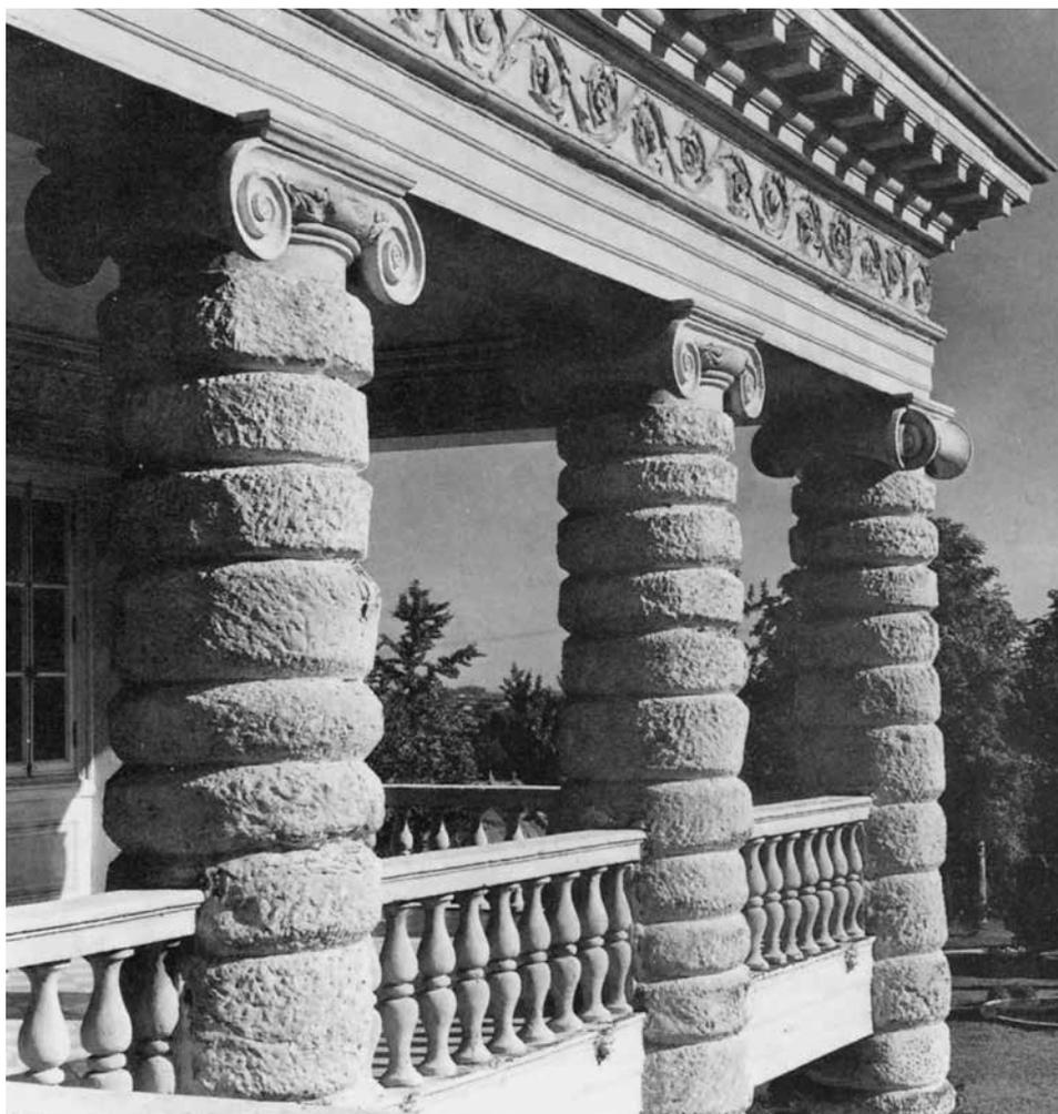
*Particolare dei due ultimi intercolumni della loggia nel lato orientale del segmento eseguito. La foto mostra chiaramente il capitello dell'ultima colonna con la voluta angolare rivolta al cortile interno. È evidente che codesto capitello è qui impiegato in modo del tutto improprio. Merita particolare attenzione l'estrema finezza delle sagome che costituiscono i tre elementi della trabeazione.*
