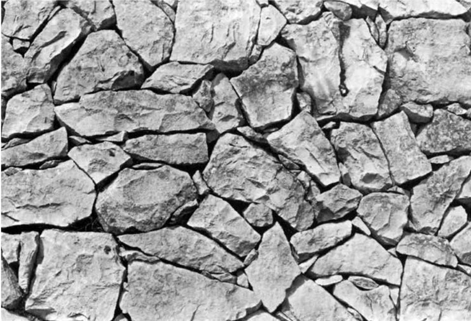
*La struttura quasi ad incastro delle marogne costruite con blocchi calcarei: ogni masso viene possibilmente fatto posare su almeno due sottostanti.*
